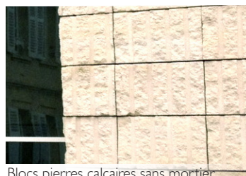
Blocs pierres calcaires sans mortier
