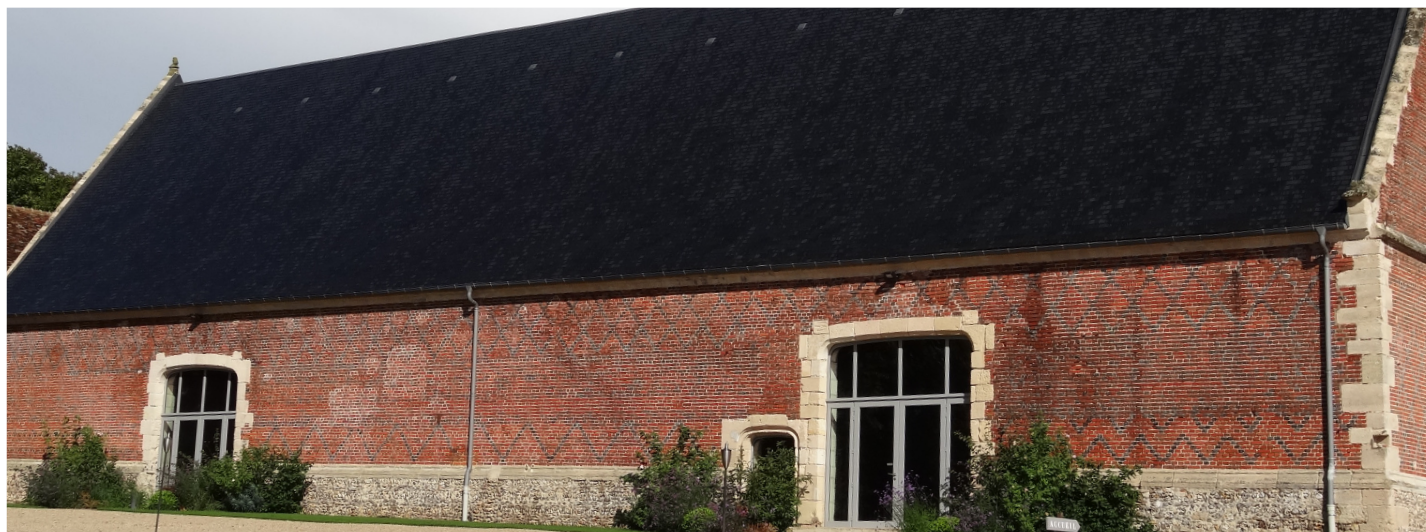
Grange convertie en locaux de séminaire (Boissy-le-Bois)
