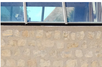
Moellons et vitrage
